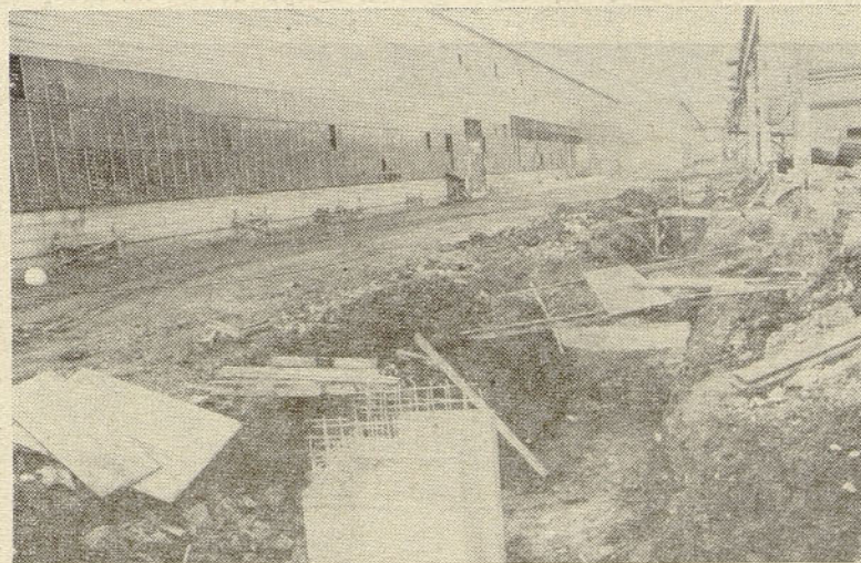
S pričetkom izkopov in betoniranjem temeljev se kažejo že tudi obrisi aneksa žarilne peči
