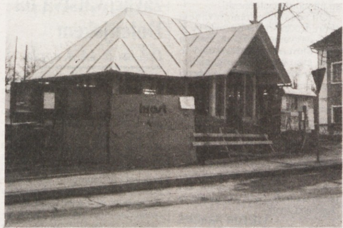
NAMESTO KIOSKA - Na črnomaljskem Trgu svobode, prav nasproti gradu, raste zgradba z lesenim ogrodjem in bakreno streho. Starejši meščani se spominjajo, da je tam nekaj stala nekoliko manjša kapelica, sprašujejo pa se, čemu bo služila omenjena hiša. Med ljudmi ne manjka tudi takih, ki se zgražajo nad omenjeno hiško, prepričani, da bo s tem še dodatno uničeno staro mestno jedro. Na občini so povedali, da je bila dokumentacija za stavbo pripravljena že leta 1994, žegen pa je dal tudi Zavod za varstvo naravne in kulturne dediščine. Sicer pa se bo vanjo preselila Tobačna tovarna s svojo trafikantsko prodajo, medtem ko bo bližnji rdeči kiosk odstranila. (Foto: M. B.-J.)
