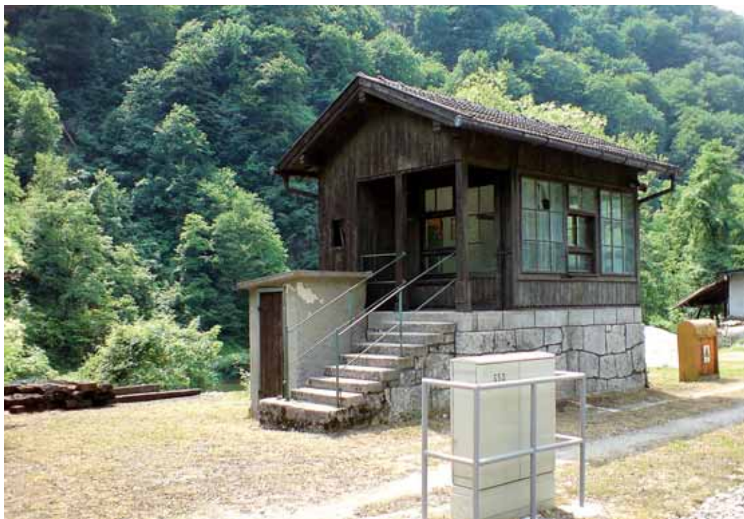
Spomeniško zaščitena kretniška postojanka v Zidanem Mostu. (foto: Bogič)
