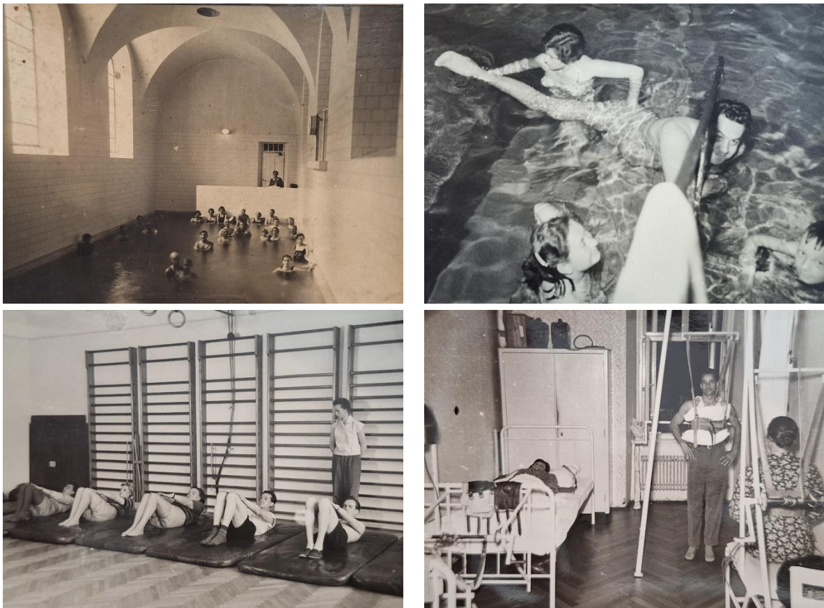
Slika 27: Bazen s termalno vodo in hidroterapija (zgoraj); telovadnica in mehanoterapija (spodaj) v nekdanjih terapevtskih prostorih Zdravilišča Laško.
