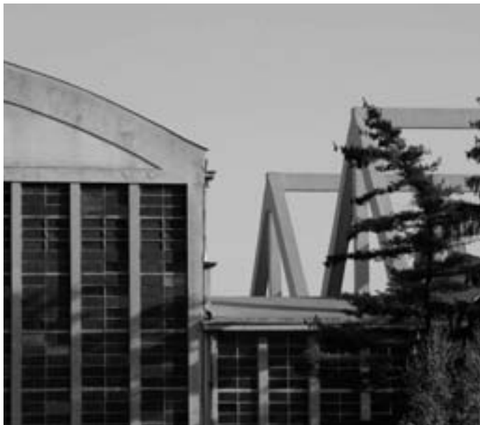
Slika 2: Objekt obdelovalnice v Litostruju je primer inovativne konstrukcijske zasnove. Obešeno streho na armiranobetonskih zunanjih vešalih je leta 1946 zasnoval Miroslav Gregorič. Foto: Miran Kambič.
