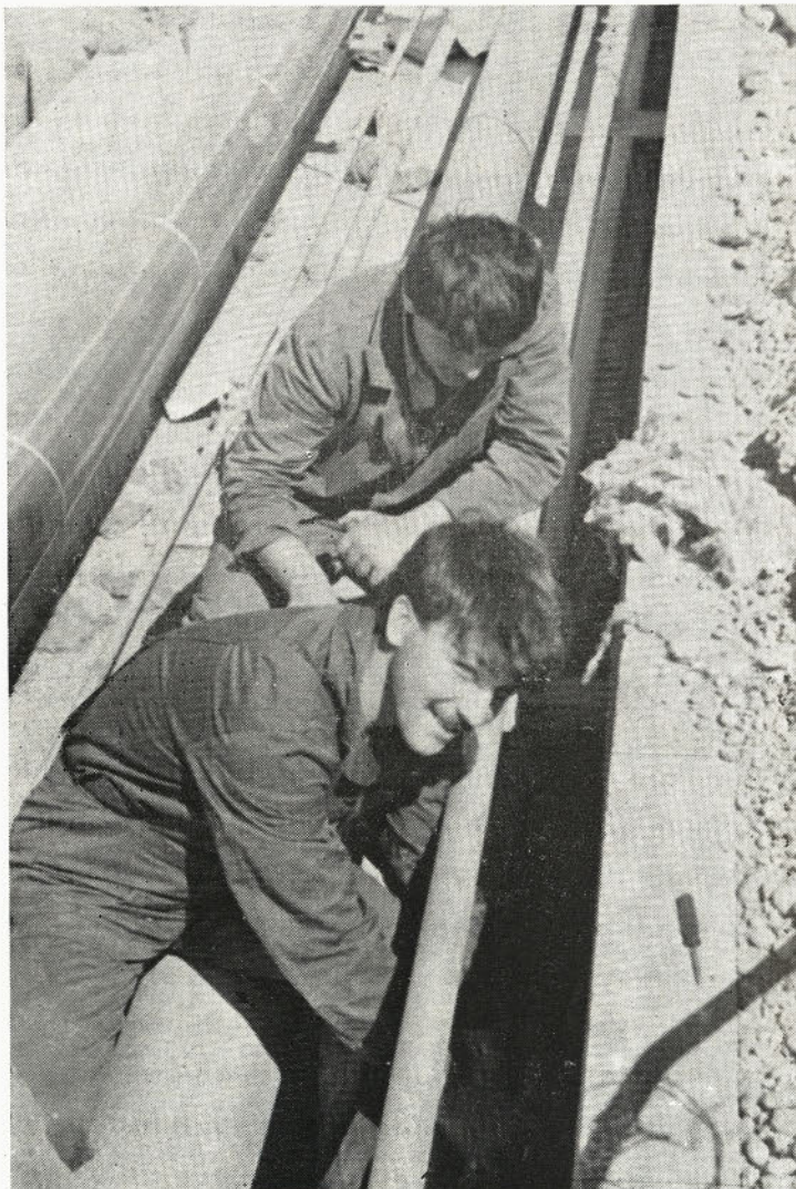
Izoliranje cevovoda
