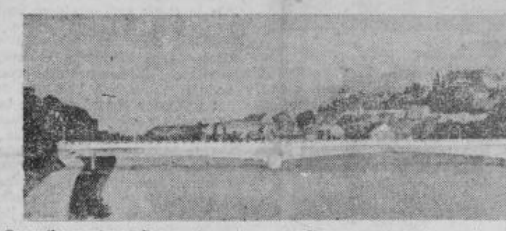
Opornika v strugi Drave sta gotova, opaži za goraje želez mostu so pripravljene in sedaj bo šlo delo hitro in nemoteno od rok
