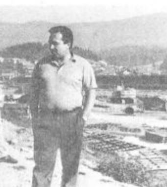
Na gradbišču centralne čistilne naprave
