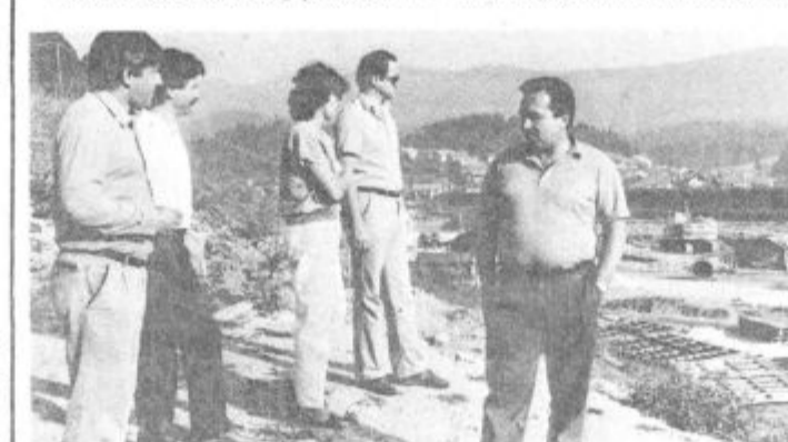
Na gradbišču centralne čistilne naprave
