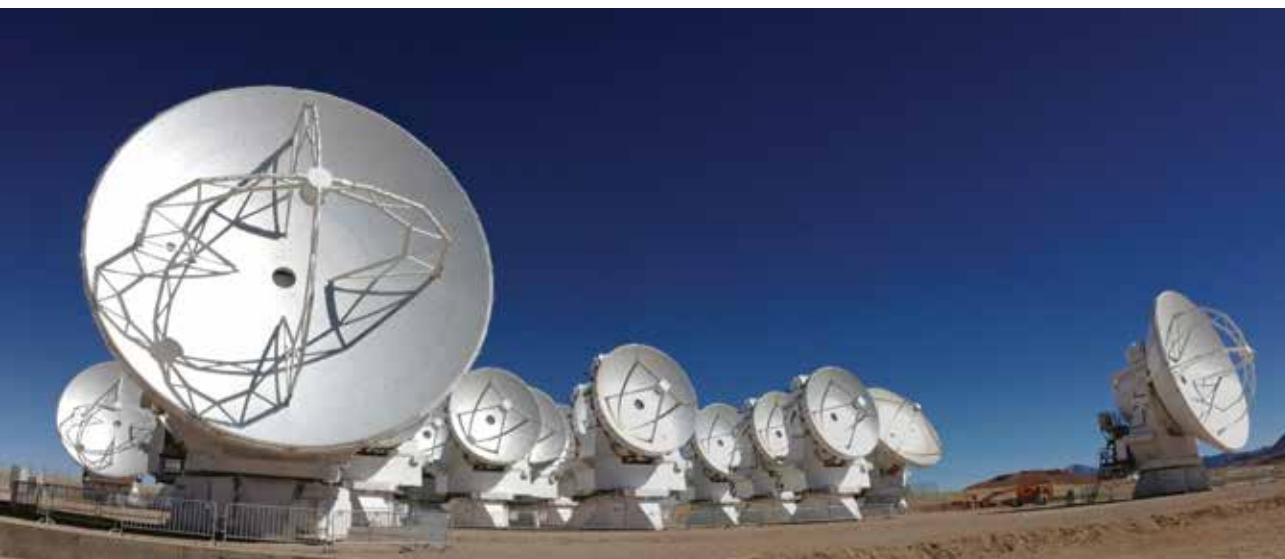
Antene ACA (Atacama Compact Array, Kompaktna mreža Atacama) imajo premer krožnika sedem metrov in so postavljene tesno skupaj. Z njimi lahko astronomi opazujejo radijske valove z valovnimi dolžinama od tri desetine do tri milimetre. Kompaktna mreža Atacama se nabaja na nadmorski višini pet tisoč metrov in je sestavljena iz dvanajstih krožnikov, ki lahko delujejo samostojno ali skupaj kot interferometer. Foto: ALMA(ESO/NAOJ/NRAO).
