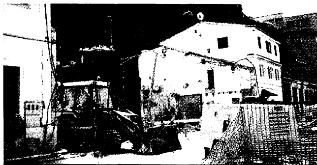
PIP, KDAJ NA FORNAČAH? - Na Fornáčah so stroji odstranili dotrajano ruševino. Na njenem mestu bodo zrasli novi prostori podjetja Projektiva inženiring Piran (PIP), ki zdaj še gostuje v baročni stavbi na Tartinijevem trgu v Piranu.
