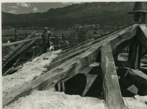
Strešna konstrukcija malega zvonika, 18. 5. 2010
