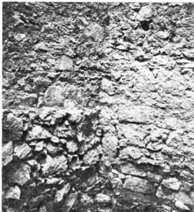
Jugovzhodni vogal v sektorju A: detajl stika med stenami stolpastega gradu in nehomogeno grajenim zidom.
