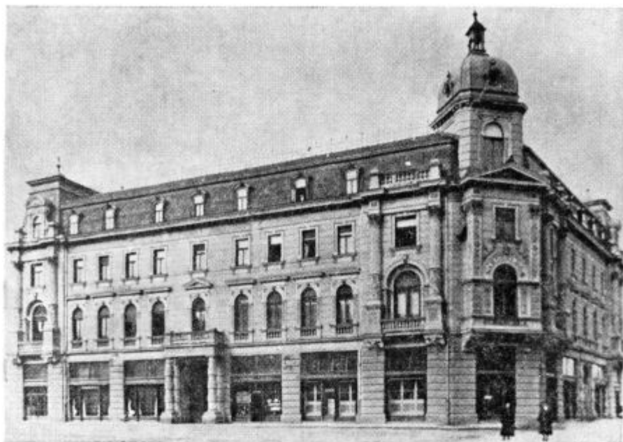
Narodni dom (1897—1941); arhitekt J. V. Hraský, sloveči profesor praške tehnike, nekdanji deželni inženir v Ljubljani; »dom narodnega dela in štedljivosti« zgradila Vošnjak-Sernečeva Celjska posojilnica (ust. 1881); 1941. pa sta mu najprej okupator, a kasneje še letalska bomba izmaličila lice
