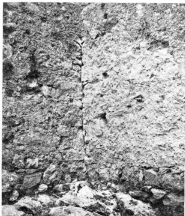
Severovzhodni vogal v sektorju B. Severna in vzhodna stena sta tudi tu enotno grajeni, kamni med seboj upeti.
