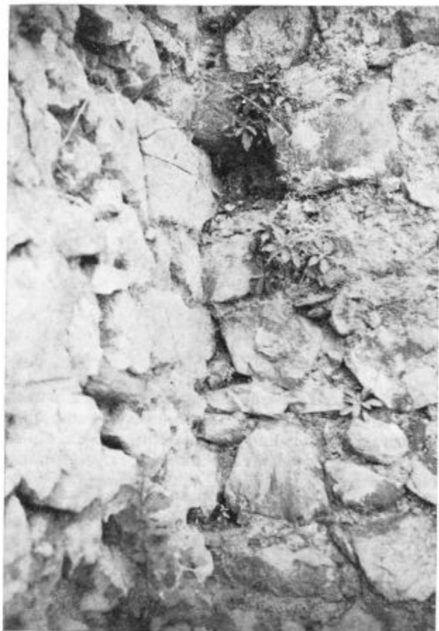
Pogled z dvorišča na stik med zahodno steno sektorja B (na desni) in severno steno najstarejšega obrambnega obzidja 2. zidane gradbene faze (na levi). Zahodna stena je z izmeničnim zasekavanjem (šivani zid) upeta v steno obzidja.
