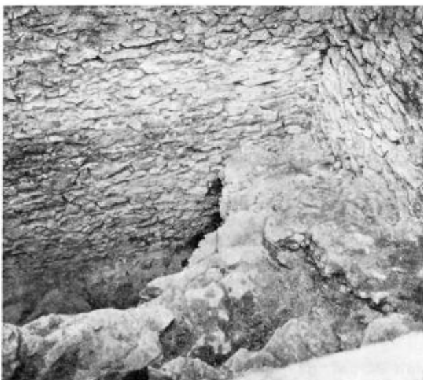
Nivo zgornjega estriha v vzhodnem delu obrambnega stolpa (sektorja C). Na levi v ospredju je živa skala.
