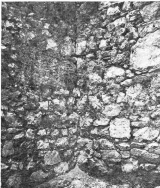
Severovzhodni vogal v sektorju B. Severna in vzhodna stena sta tudi tu enotno grajeni, kamni med seboj upeti
