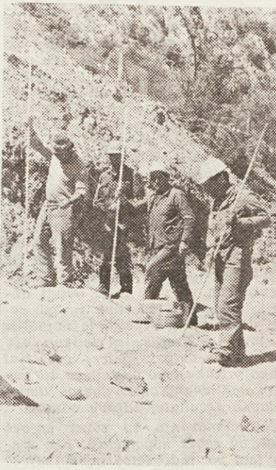
Prve priprave za novi most v Mostarju. Na delu so minerji, ki pripravljajl jamo za opornik
