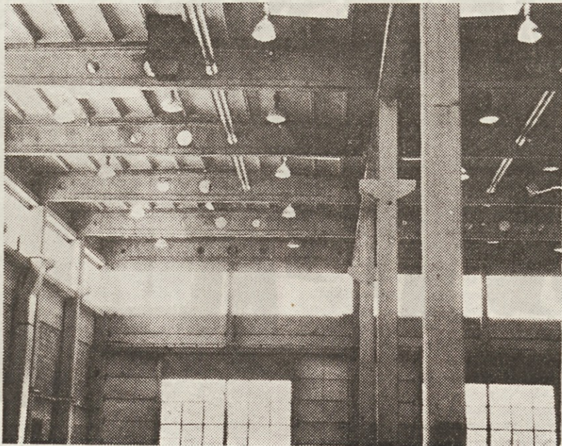
Takole izgleda strešna konstrukcija nove hale
