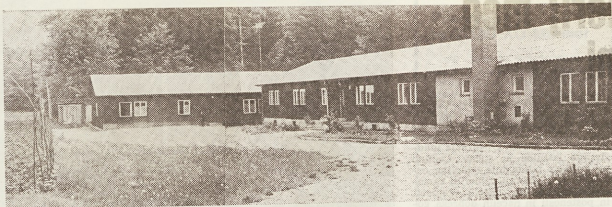
Poleg stare stanovanjske barake so postavili še novo, ki nudi streho 20 delavcem
