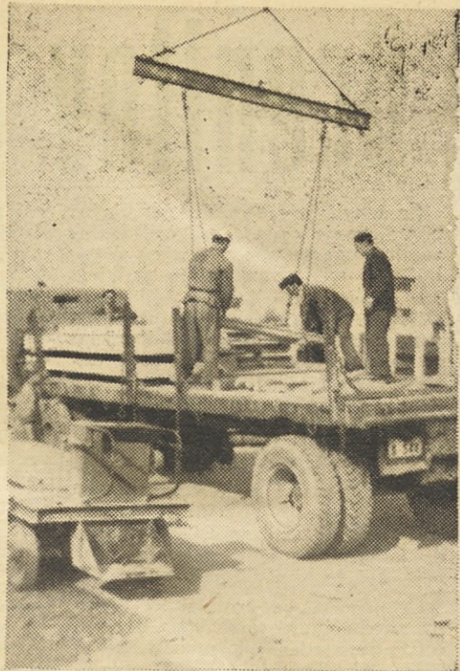
Odvoz elementov na gradbišče
