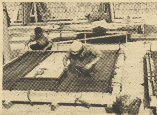
Zabetonirane predelne stene
