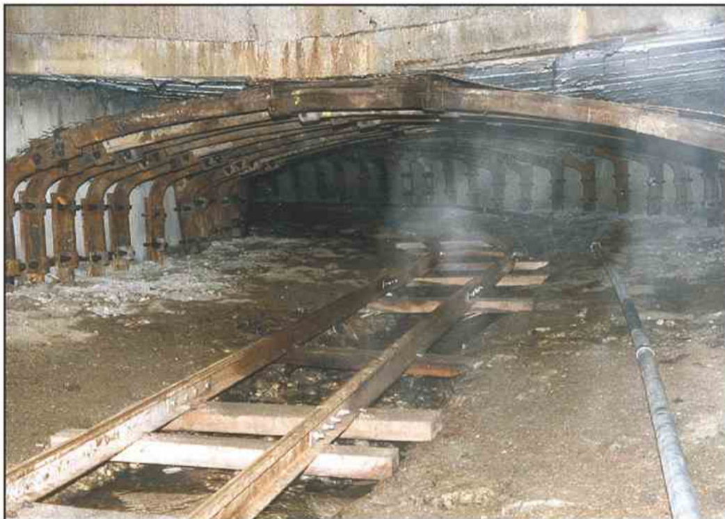
Delo v kanalu je za delavce težko, ker je višina ponekod komaj meter (Foto:vos).
