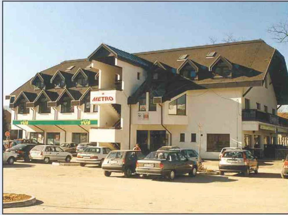
Nazarje: Izolesova poslovno-stanovanjska stavba. (Foto: J.P.)
