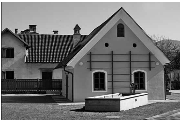
Prenovljen vaški vodnjak v Hrovači pri Ribnici (Foto: G. Kranjec)
