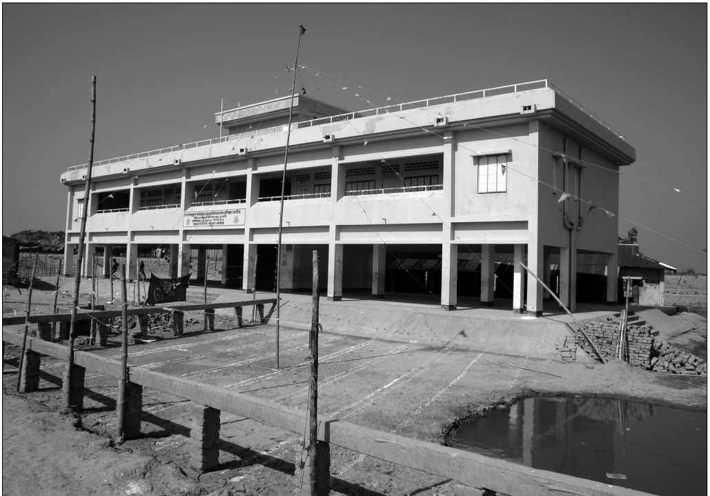
Fotografija 2: Protipoplavno zatočišče, kakršne na ogroženih območjih gradijo nevladne organizacije v sklopu mednarodnih projektov za krepitev prilagoditvene zmogljivosti. Stavba, v kateri je osnovna šola, ob poplavih dobi vlogo zatočišča (avtor: Jurij Kočar).
