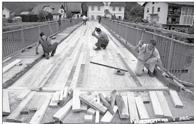
Most v Spodnji Rečici so obnovili delavci Komunale Mozirje.
