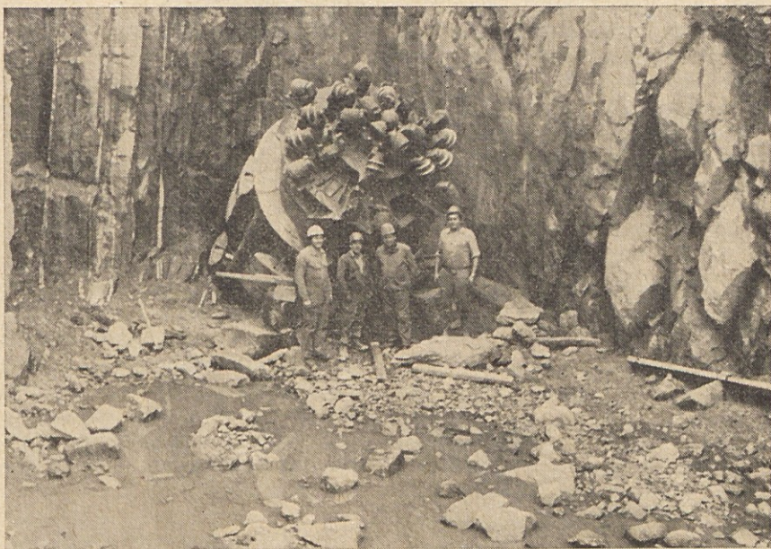
Rudarji Zasavskih premogovnikov — TOZD Rudarska gradbena dejavnost, so prevrtali zračilni nadkop Bätzberger za cestni predor St. Gotthard v Svici. Dolžina nadkopa znaša 510 m, premer pa 3 m. Na fotografiji skupina naših sodelavcev.
