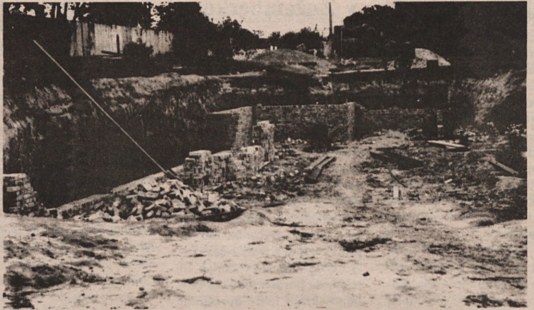
Začetki gradnje cerkve sv. Cirila in Metoda v Melbournu
