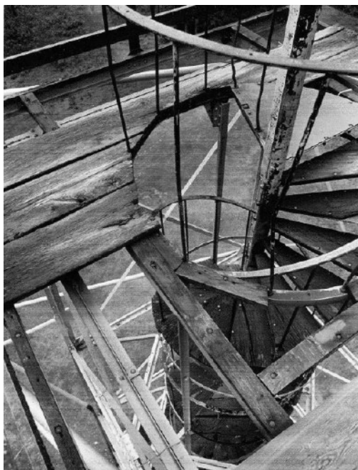
Slika 4: Razpadajoči podest na stolpu. Foto: 84 Igor Napast, 23. 8. 1988.
