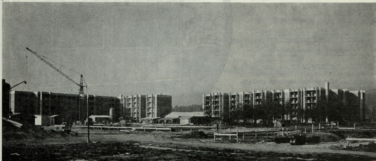
Petetažni stanovanjski bloki v Novih Dravljah v Ljubljani, ki so grajeni po protipotresnem sistemu PRSF
