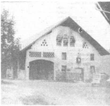
Gospodarsko poslopje Stanega Škofa je spet pod streho
