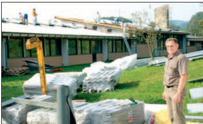
Inženir Andrej Jereb se je prepričal, da so stare plošče pred odvozom na deponijo zavili v polivinil in povezali.
