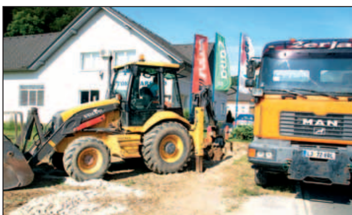
Zaradi uporabe težje mehanizacije ob izkopu jarkov in betoniranju so na cesti postavili ustrezne prometne znake o omejitvi hitrosti, ki jih žal vsi niso upoštevali.
