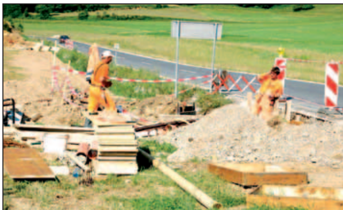
Izkop in betoniranje jaškov za komunikacijski kabel
