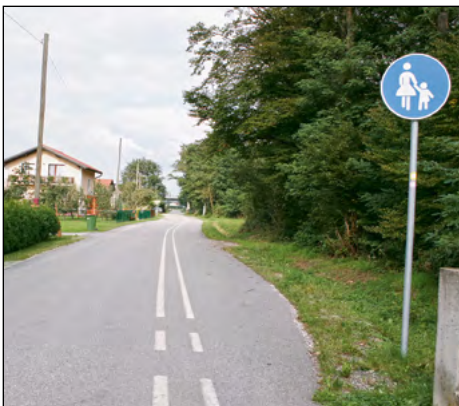
Kanalizacija in pločnik na Zg. Hajdini preko proge
