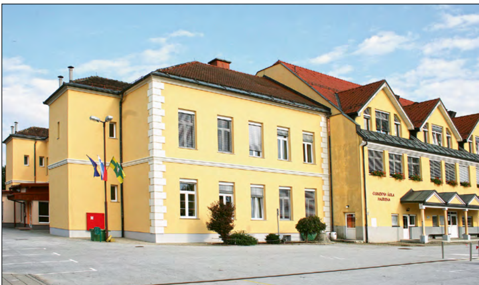
Med letošnjimi poletnimi počitnicami je bila na starejšem delu šolske zgradbe izvedena energetska sanacija.
