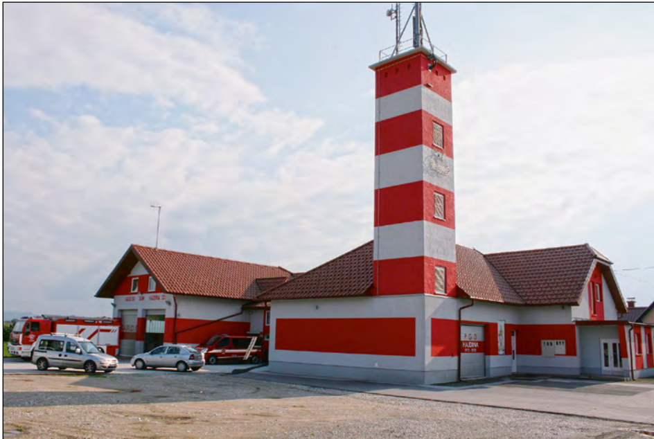
Ob 100-letnici je novo podobo dobil tudi gasilski dom PGD Hajdina, ob njem pa je občina poskrbela za rušenje starejše hiše in razširitev parkirišča.
