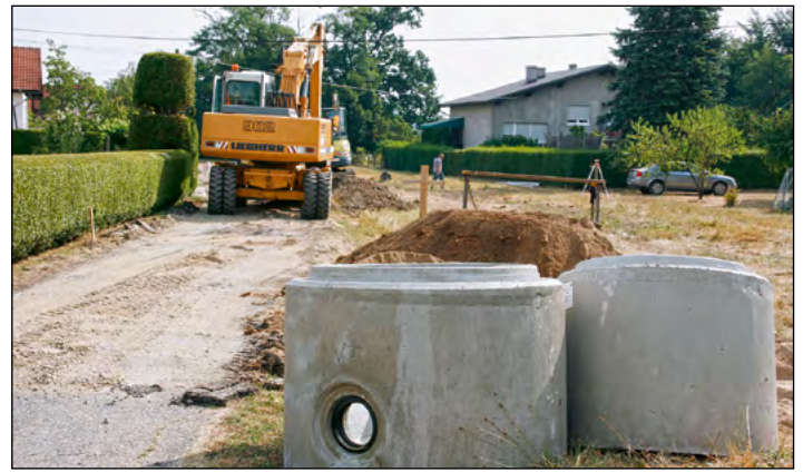
Izgradnja kanalizacije in razsvetljave v ulici pri Mohorku v Skorbi
