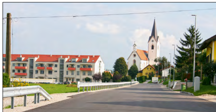
Letos poleti je bila zaključena rekonstrukcija ceste in pločnika od PSC do Sitarjeve kapele na Zg. Hajdini.
