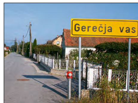
Kanalizacija, vodovod v Gerečji vasi
