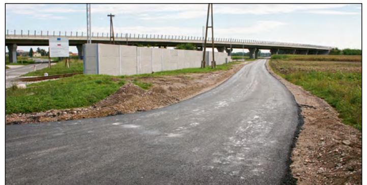
20. septembra je modernizirana cesta ob železnici od Zg. Hajdine do Dražencev.
