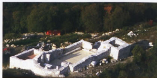
Obnovljene ruševine cerkvenega kompleksa na Sabotinu
