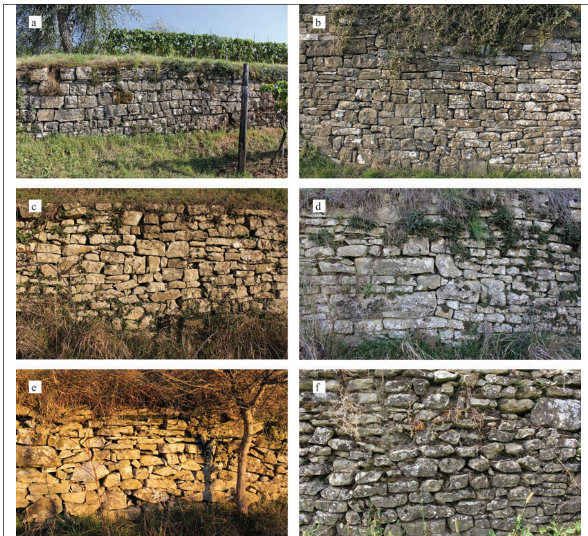
Slika 13: Tipovi suhozida oprtljskih terasa obzirom na materijal i tehniku gradnje, a) Veći i pravilni blokovi kamena slagani u pravilne redove (jugozapad obuhvata), b) Mješavina većih i manjih pravilnih blokova kamena (istok obuhvata), c) Mješavina pravilnih i nepravilnih kamena slaganih u neuredne redove (zapad obuhvata), d) Veliki, pravilni blokovi kamena unutar zida (zapad obuhvata), e) Zid većinom zidan nepravilnim kamenim blokovima u neurednim redovima (zapad obuhvata) f) Većinom zaobljeni kameni blokovi slagani u pravilne redove (sjever obuhvata).
