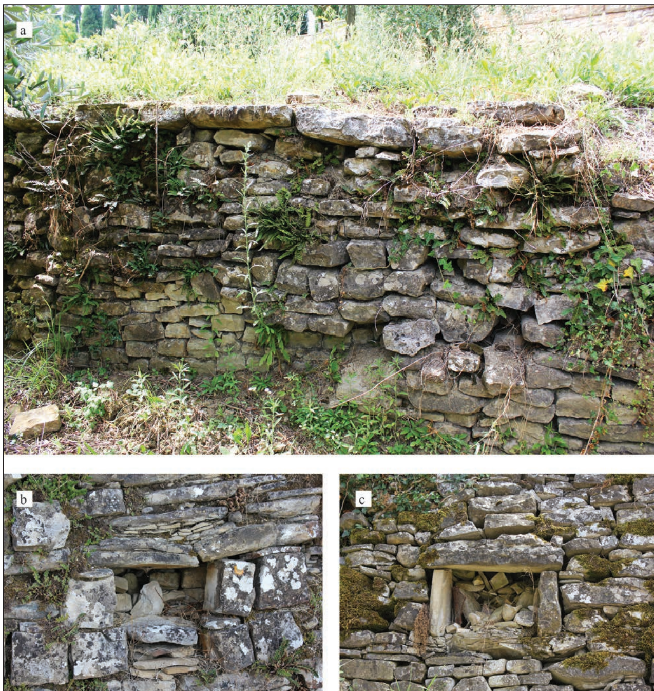
Slika 15: Posebnosti potpornih suhozida a) Završetak zida s većim i položenim komadima kamena, b) Niša u sjevernom dijelu obuhvata, c) Niša u zapadnom dijelu obuhvata.
