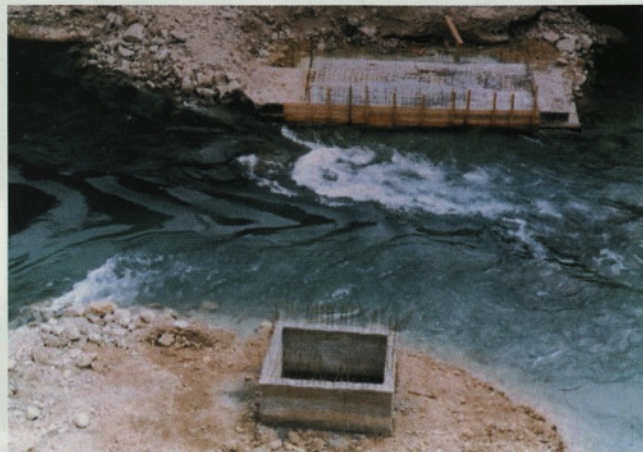
Slika 2 • Izdelava temeljev začasnih stebrov
