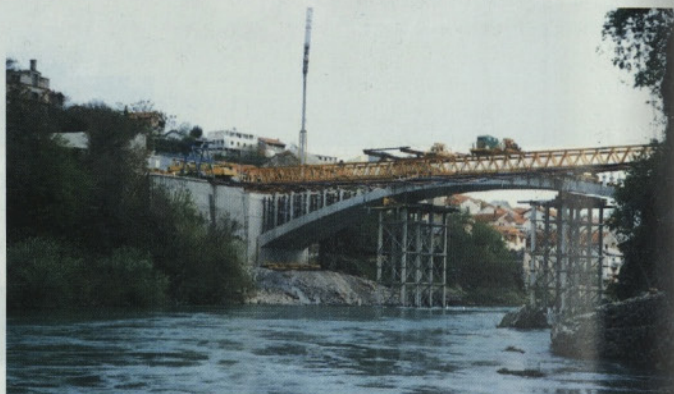
Slika 6 • Izdelava nadločne konstrukcije
