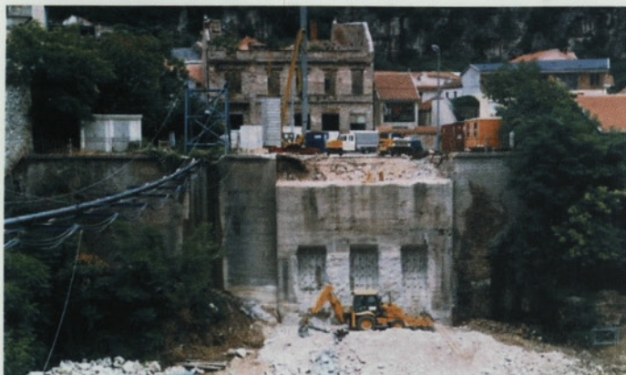
Slika 3 • Izdelava temelja loka na desnem oporniku
