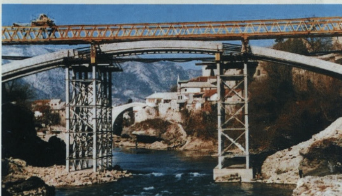
Slika 5 • Montirani nosilci z razmakom za mokri stik
