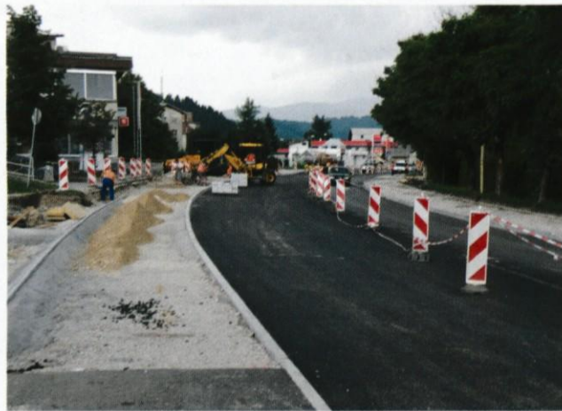
Samo še zgornja plast asfalta.
