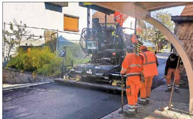
Oktober so zaključili z asfaltiranjem priključkov na glavno cesto. (Foto: arhiv Občine Gornji Grad)
