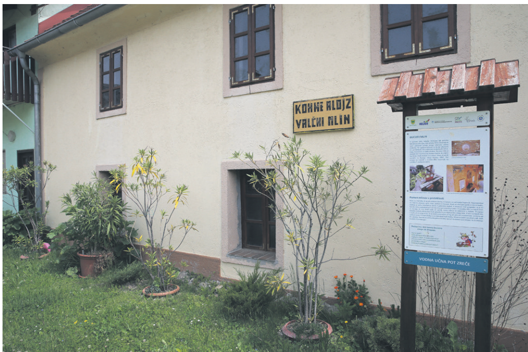
Bucijev mlin je bil zgrajen kot nadstropno zidana stavba in predstavlja valjni tip mlina.
