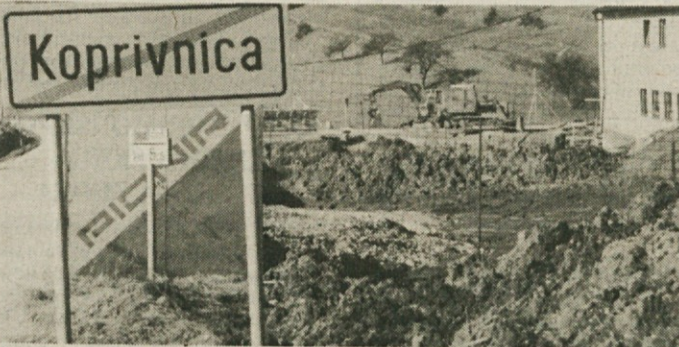
JESENI KONČNO TELOVADNICA - Sredi februarja so Pionirjevi delavci začeli pripravljati gradbišče za koprivniško telovadnico. Projekt zanjo je bil narejen že ob gradnji šolske stavbe (1974), vendar nikoli realiziran. Tako so ves ta čas učenci imeli oder, a ne dvorane, in garderobe, a ne tudi telovadnice. Telovadnico z zunanjimi merami 27 x 18 metrov naj bi dokončali do konca julija, da bi bila nared za novo šolsko leto. Predračunska vrednost zgradbe je 68 milijonov tolarjev, ki jih bosta zagotovili občina in država. (Foto: B. D. G.)
