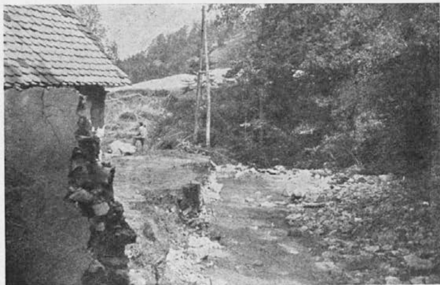
Fot. 5. Pri Antonu Kersniku v vasi Turno je potok za 1 m poglobil strugo in pri bočnem vrezovanju odnesel del hiše.
