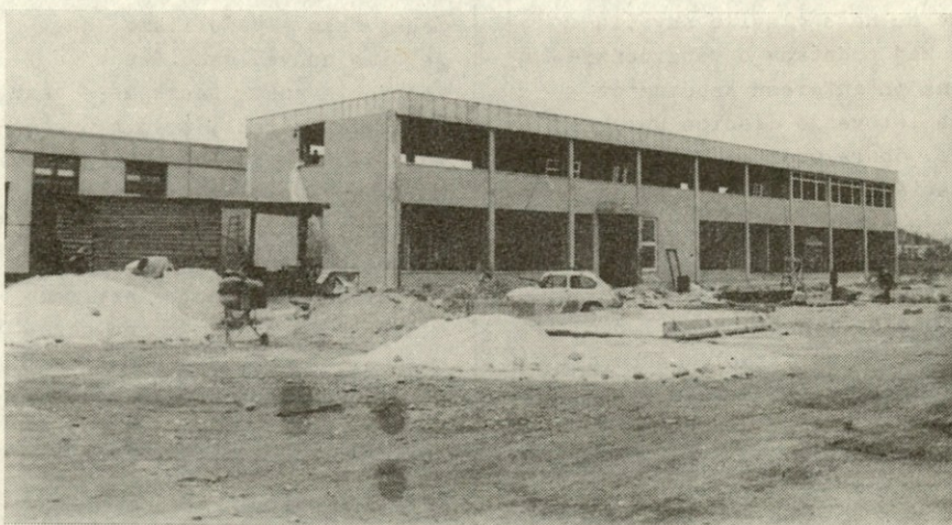
Začetek vstavljanja okenskih okvirov v prvem nadstropju upravne stavbe
