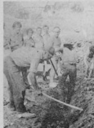
Takole je treba urejati haloške ceste FOTO: B. VODUŠEK
