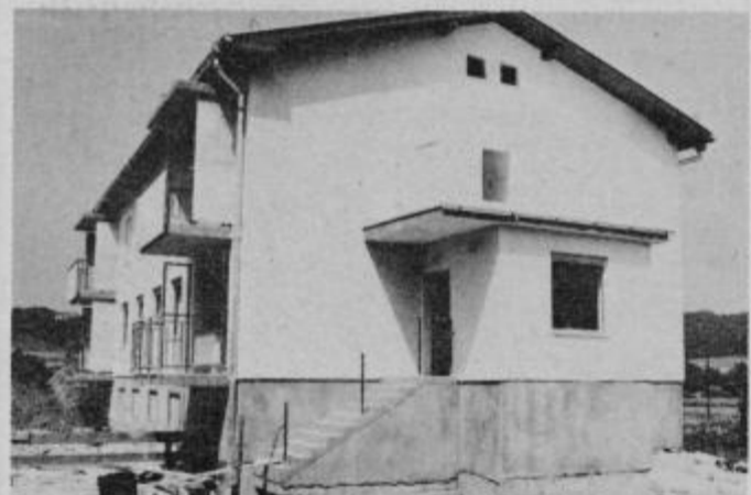
Poslovno stanovanjska zgradba v Podlehniku pred dograditvijo.
