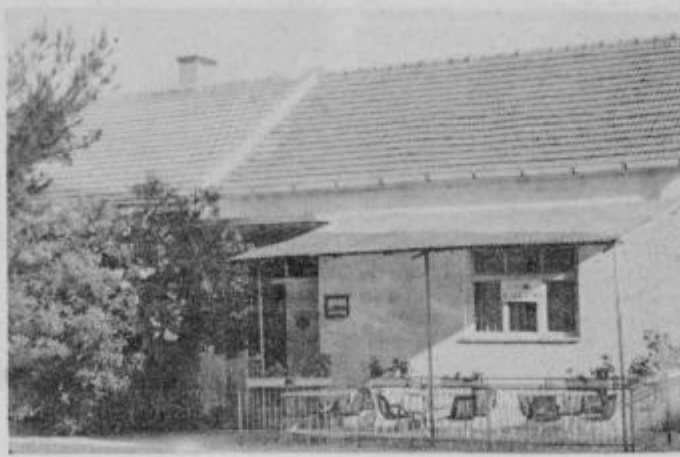
Pogled na prostor, kjer je jedilnica in kuhinja
