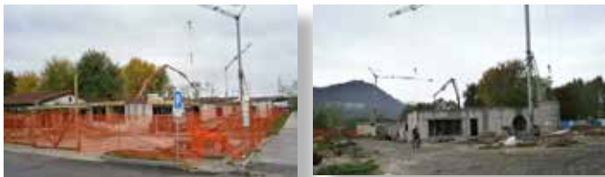
Gradnja vrtca na Brodu v polnem zamahu
