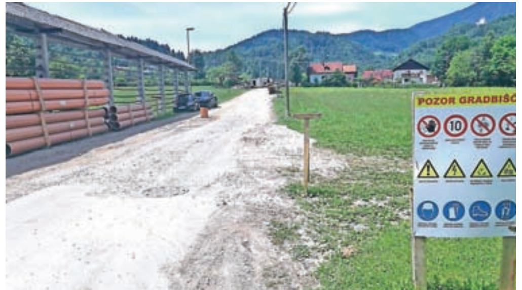
Zaradi gradbišča po glavni cesti skozi naselje velja popolna zapora, obvoz je urejen, s tem pa tudi dostop do izhodišča za Kamniški vrh in planino Osredok. / FOTO: JASNA PALADIN
