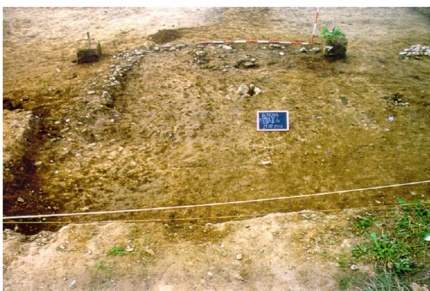
14 Faza II: temelji objekta SE 102 in SE103.
