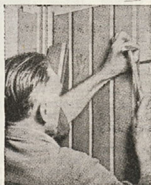
»Oblačenje« sten montažnih hišic s plastiko
