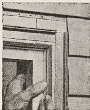
»Oblačenje« sten montažnih hišic s plastiko
