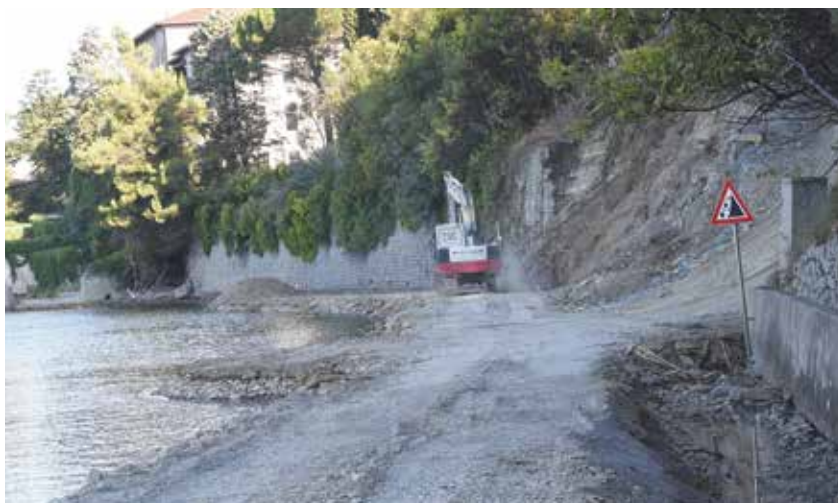
Tovrstne gradbene posege bi bilo bolje izvajati izven turistične in kopalne sezone. / Sarebbe meglio che tali interventi si svolgessero al di fuori della stagione turistica e balneare. (Foto: Občina Ankaran / Comune di Ancarano)
