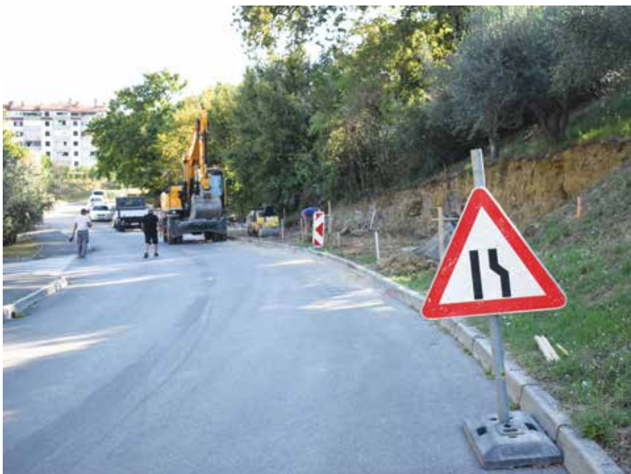
Z optimalnejšo rabo prostora se bo število parkirnih mest podvojilo. Na tem območju trenutno še potekajo gradbena dela. / Con un uso più razionale dello spazio, il numero di posti auto raddoppierà. In quest'area sono attualmente in corso lavori di costruzione. (Foto: Občina Ankaran / Comune di Ancarano)
