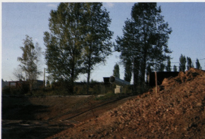
Na robu gudronkse jame je nameščen velik ventilator, ki razpiha atmosfero nad gudronom, če se v neugodnih vremenskih razmerah (brezvetrje) nad laguno nabere previsoka koncentracija žveplovega dioksida.
