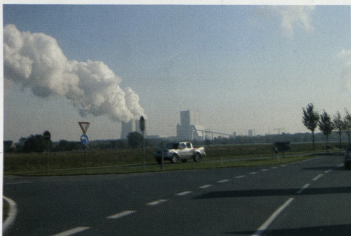
Naslednje jutro nas je v soncu pričakala TE Schwarze Pumpe, ki se razlikuje od večine termoelektrarn zato, ker nima značilnega dimnika. Dimni plini so namreč po procesu čiščenja in ohlajanja speljani kar v hladilne stolpe. Zato elektrarna od daleč bolj spominja na jedrsko kot termoelektrarno.
