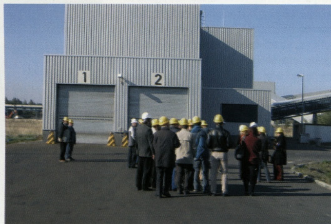
Nas je najbolj zanimala vhodna enota za solidifikat gudrona oziroma druge posebne odpadke, ki jih (so)sežigajo v obiskani elektrarni. Obrat predstavlja nekakšen hangar za dva velika tovornjaka, ki streseta odpadke na posebne vibracijske rešetke.
