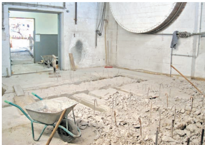
... v teh dneh so strojnico odstranili, zalili bodo nove betonske temelje in čez mesec dni vgradili elemente nove strojne opreme.
