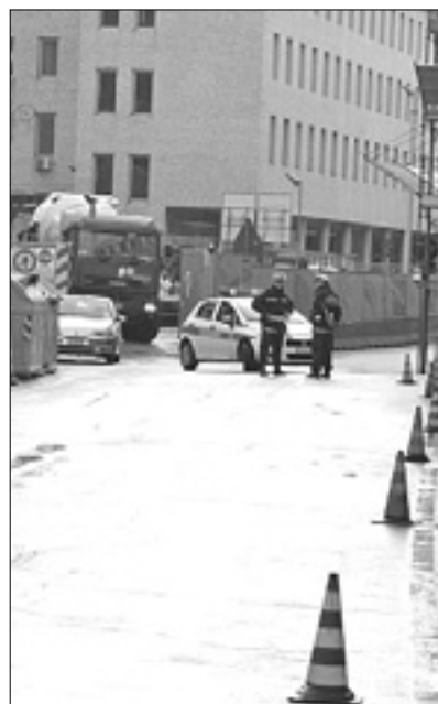
Izvoz z gradbišča ...
