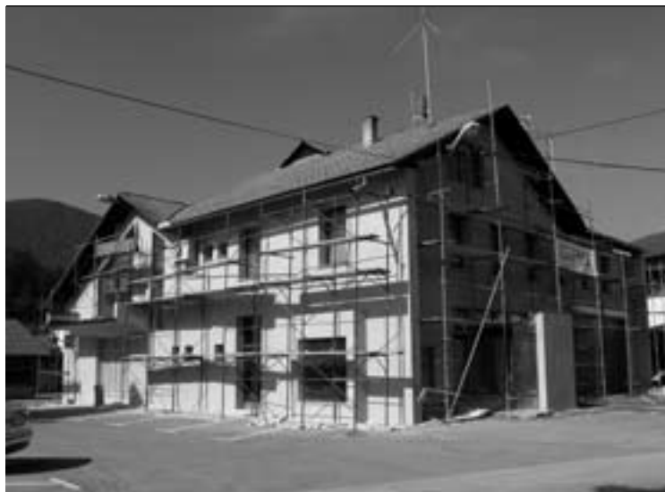
Potekajo še zadnja dela pri obnovi fasade.
