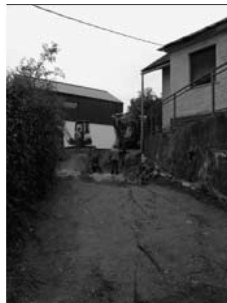
Občina Ig nadaljuje z izgradnjo kanalizacijskega omrežja v naselju Ig (Čevljarska ulica). Foto: Katja Ivanuš
