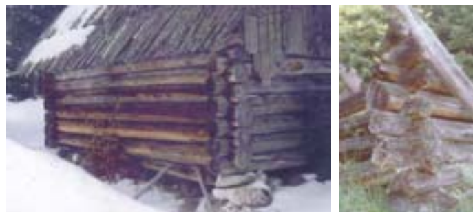
Sliki 4,5: Senik - "svisli" na Uskovnici ter detajl vogalne vezi (foto: J. Kušar). Hayloft - "svisli" on Uskovnica and a detail of corner binds.
