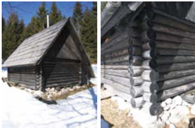
Sliki 14, 15: "Vorenčeve svisli" po obnovi in detajl vogalne zveze (foto: D. Kušar).
