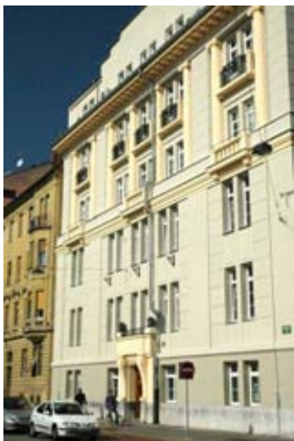
Slika 8: Odtočni žleb na stavbi bivše Trboveljske premogokopne družbe d.d., Cankarjeva ulica. Gutter on the former Trbovlje Coalmining Company Building, Cankarjeva Street.
