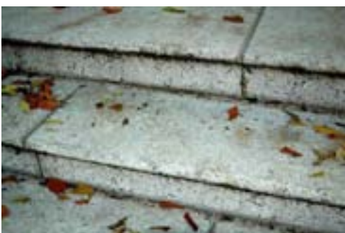
Slika 5: Stopnišče pred Glasbeno matico, Vegova ulica. Stairway in front of the Philharmonic Society, Vegova Street.
