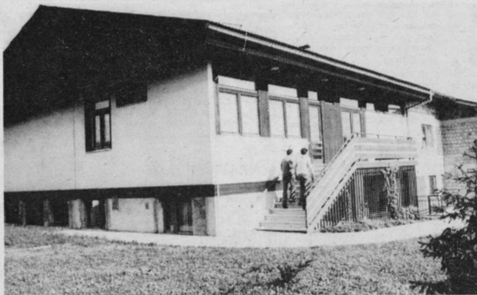
V prvem delu je vrtec, ki je bil zgrajen in odprt leta 1979, v njem pa je prostora za 50 otrok. V tej stavbi, ki je zgrajena iz Vegradovih elementov DOM 101 so trenutno tudi prostori za ostale dejavnosti, ki se bodo kmalu preselile v prizidek, kjer bo še več prostora za najrazličnejše dejavnosti.
