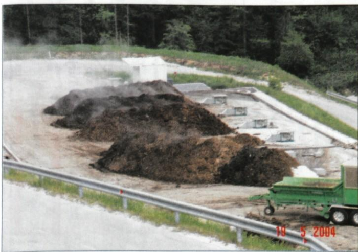
Del kompostarne, utrjene asfaltirane ploščadi z urejeno odvodnjo v zbirni
