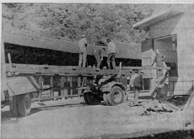
Začeli smo s pripravami za postavitve tretjega razpenjalno sušilnega stroja v oplemenitilnici
