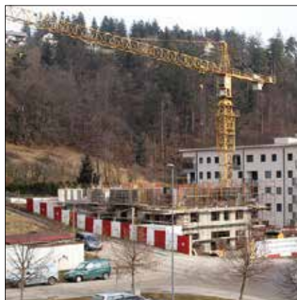
Zadnji objekt, lamelo A v večstanovanjski stavbi Podrožnik Mozirje pospešeno gradijo.
