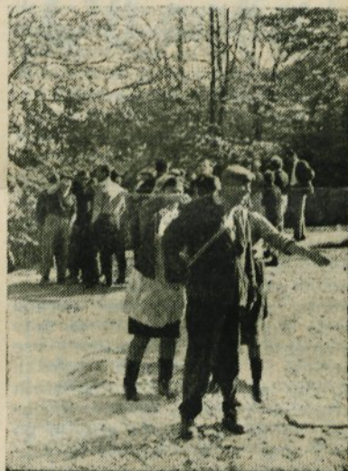
Veselo razpoloženi vaščani s Florijanovega po obnovitvi mostu
